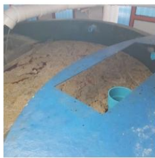
ถัง KITCHEN WASTEWATER
